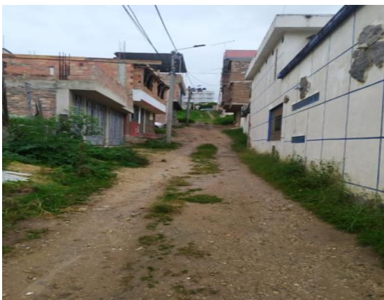
Figura 4 Estado actual de la vía
