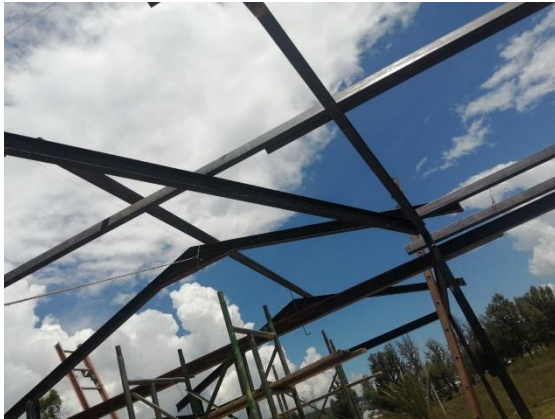
Dentro de los testeros está el amarre de vigas
