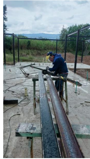
Cerchas – trabajo en obra
