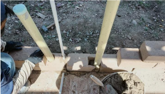
Paso de tuberías entre los muros
