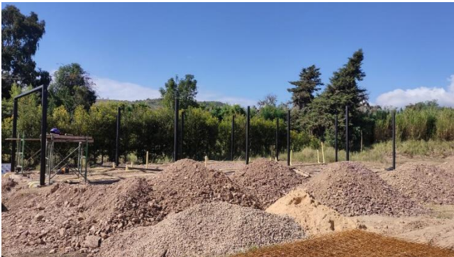
Levantamiento de Columnas
