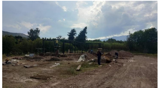
Columnas y vigas
