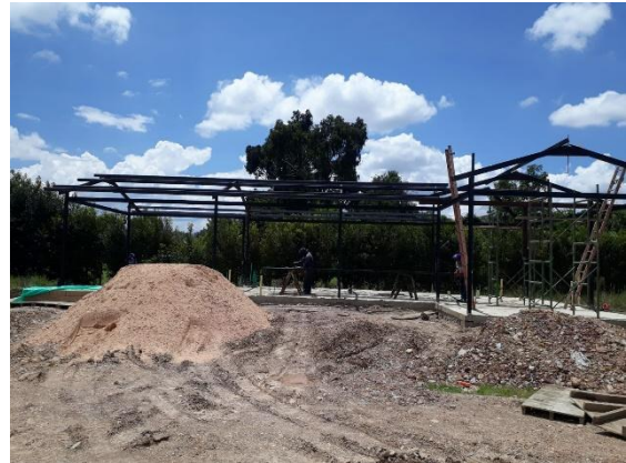
Detalles de estructura
