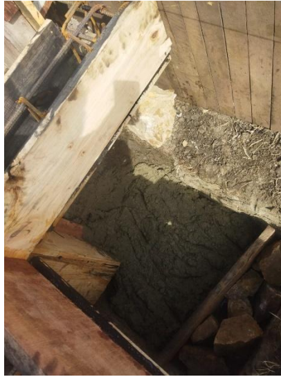
Fundición de zapatas
