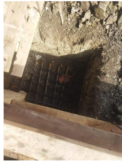
Detalle de la zapata sin armar
