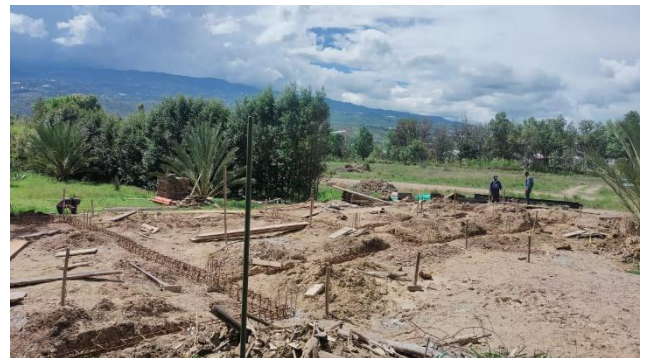
Excavación salón social
