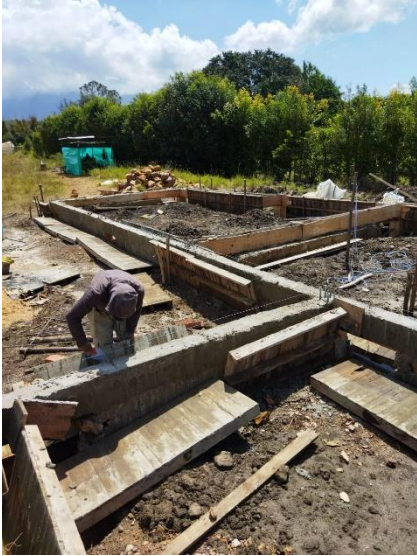
Desenfofrado de las vigas
