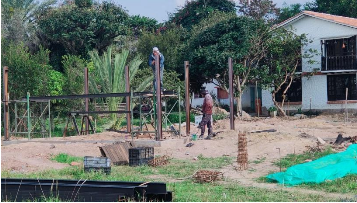
Montaje de cerchas
