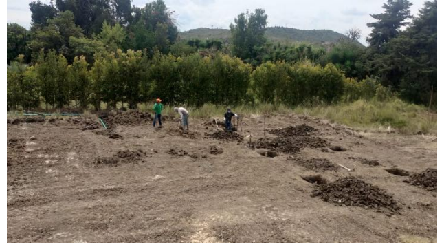
Excavaciones de zapatas
