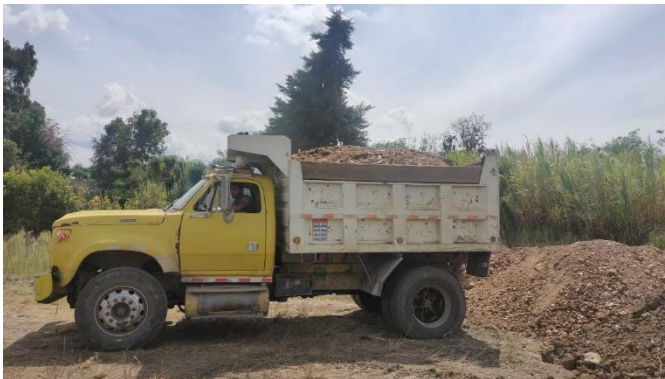
Recibo de material (arenas y gravas)
