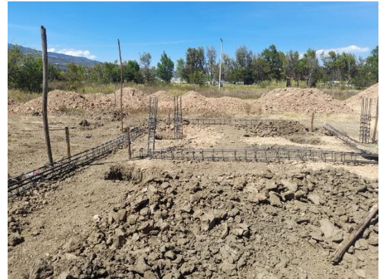
Montaje de las vigas amarradas
