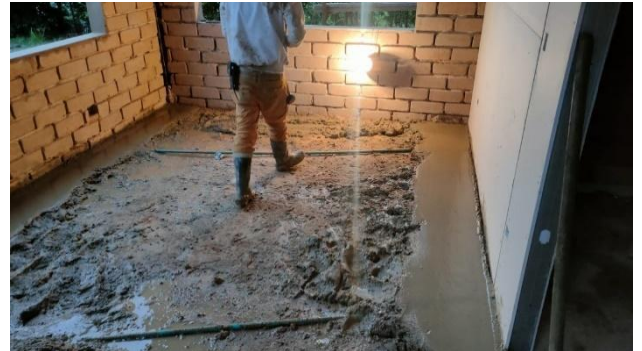
Fundición sobre pisos
