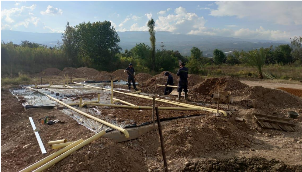
Figura 9 Montaje parte sanitaria
