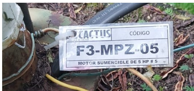
Figura 3-5 Placa característica de bomba de pozo profundo
