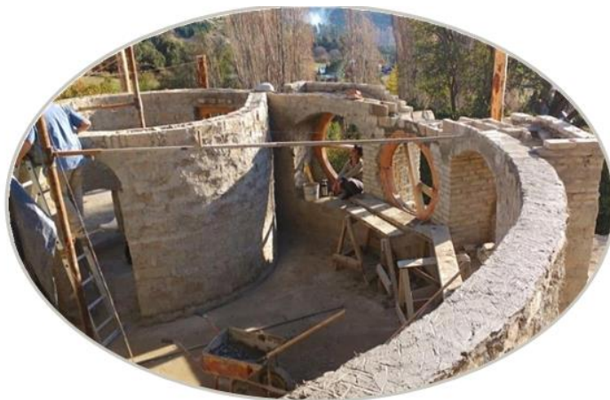
Ilustración 39. Construcción de vivienda en adobe
