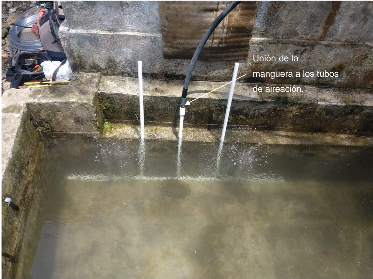
Figura 21 Unión de manguera suministradora de agua a los tubos de aireación
