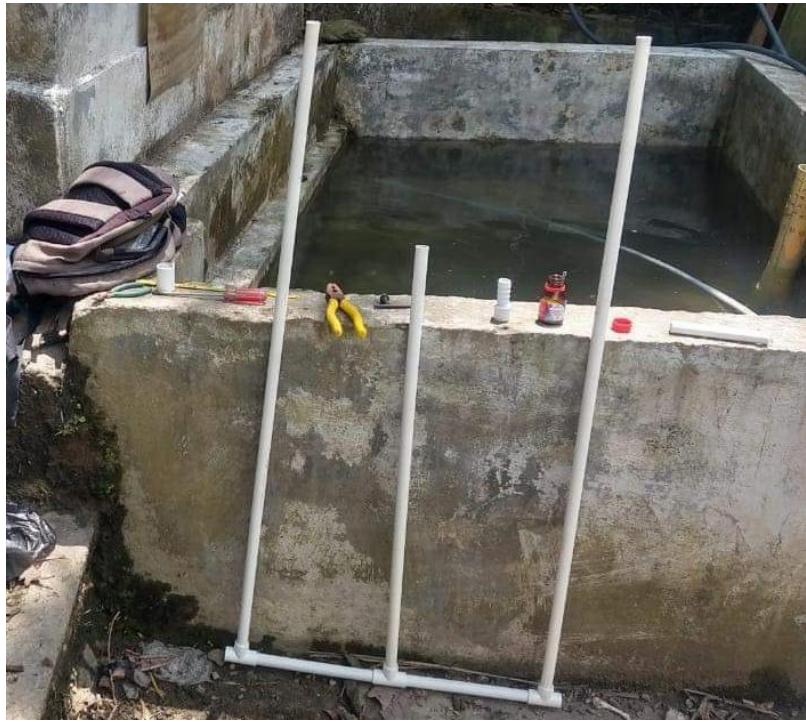
Figura 19 Ensamblaje de los tubos aireadores
