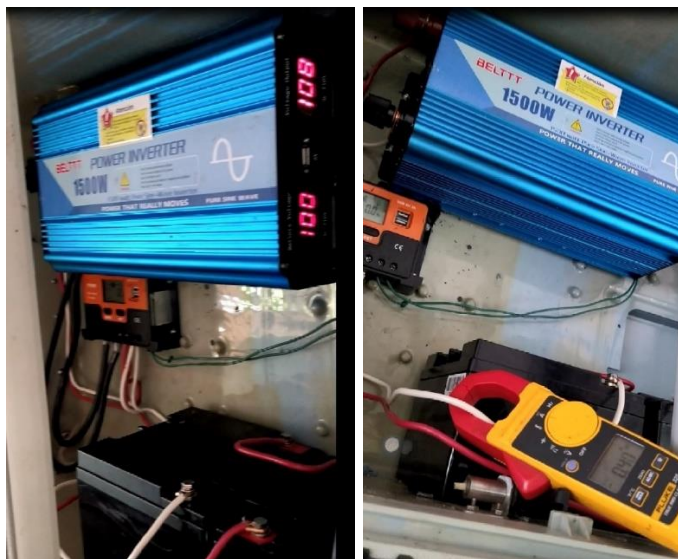
Figura 35. Gabinete con sistema de control, regulación y almacenamiento.
