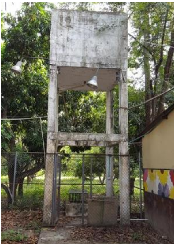
Figura 1. Tanque elevado colegio Marco Fidel Suarez, sede 4
