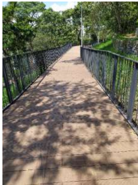
Imágenes No. 37 Imagen de la plazoleta en Deck madera plástica Bosque Encantado
