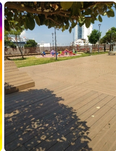
Relación del comportamiento térmico del material Deck a la sombra y al sol. (diferencia de 21°C)
