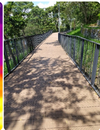
Relación del comportamiento térmico del material Deck a la sombra y al sol. (diferencia de 14°C)
