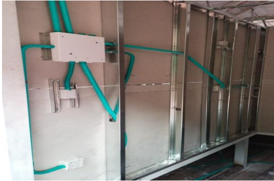
Foto 5: Instalacion de ductos caja de distribucion.
