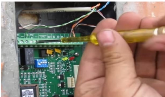
Foto 9. Instalación tarjeta video portero exterior.
