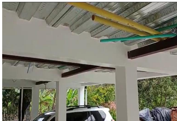
Foto 3: Entrepiso del proyecto.
