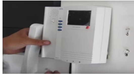
Foto 11: Instalación Video portero interior.
