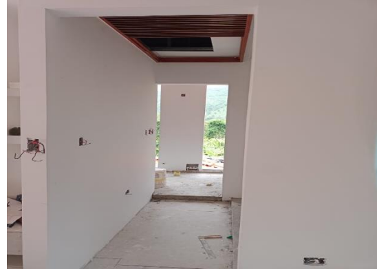
Foto 6: Alambrado Interruptores.
