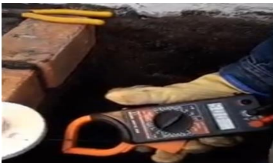
Foto 14: Medición de Intensidad electrodo.
