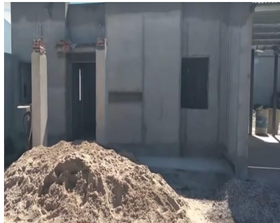
Foto 2: Construcción del proyecto.
