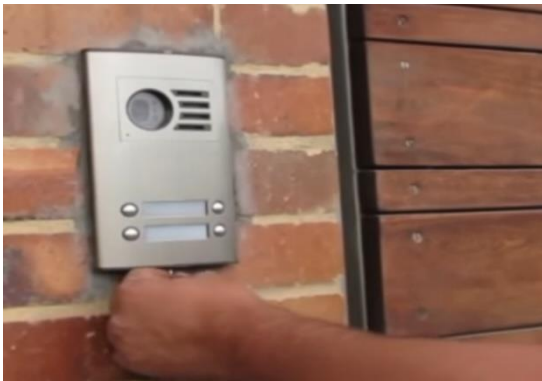
Foto 10. Instalación tapa frontal video portero exterior.
