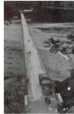
Ilustración 18. Puente Eduardo Santos.
