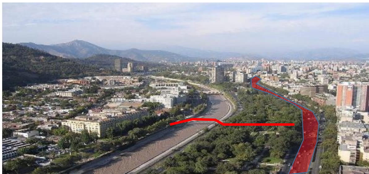
Ilustración 27. Estado actual de la ronda.
