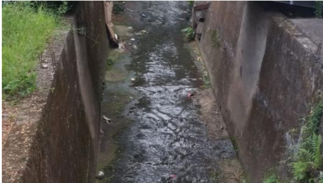
Ilustración 13. Fotografía tomada del estado actual del Caño Gramalote
