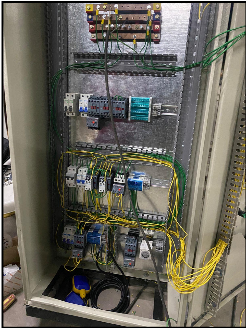
Figura 30 Construcción módulos de practicas
