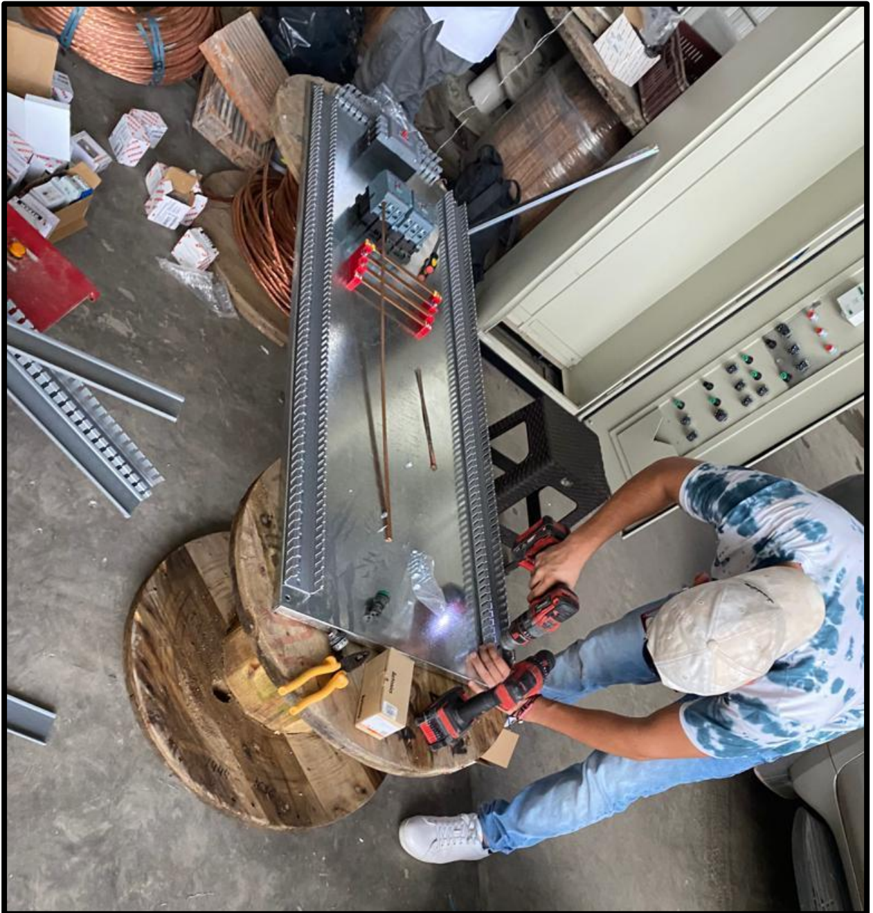
Figura 25 Construcción de tablero interno
