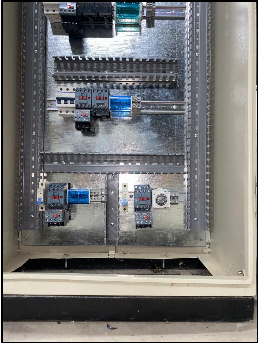
Figura 28 Montaje modulo inferior
