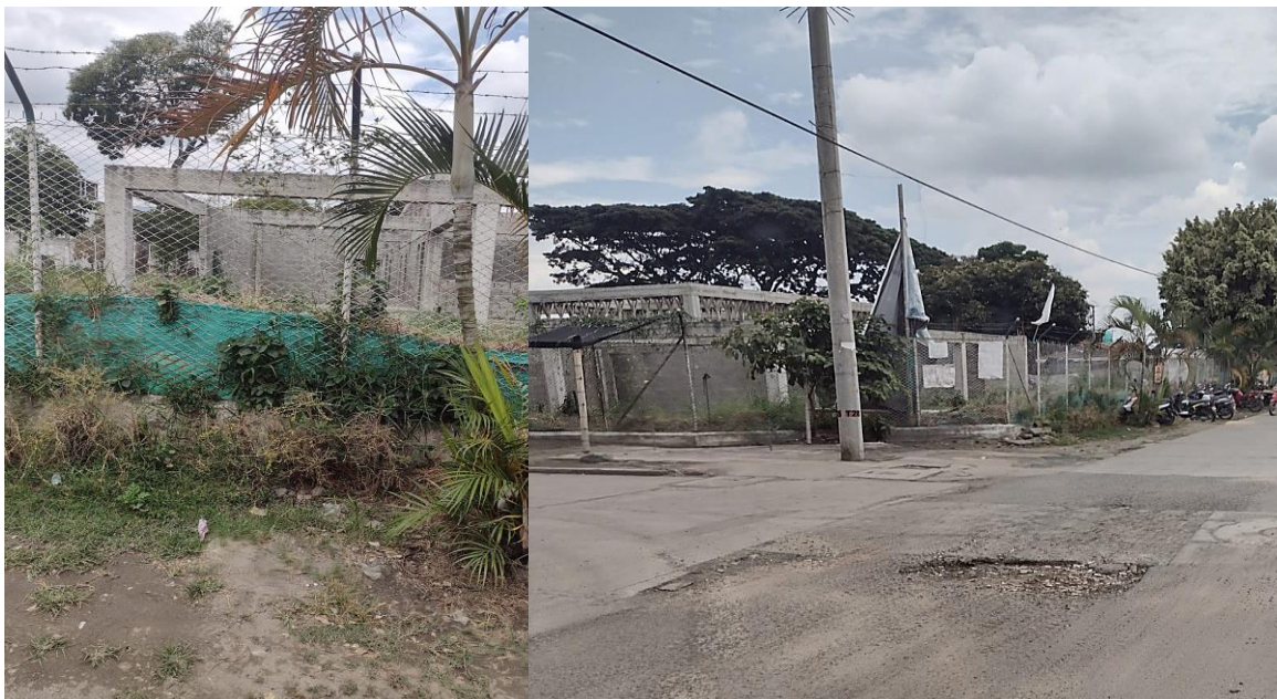
Figura 61. Zona verde en abandono y calles en mal estado
