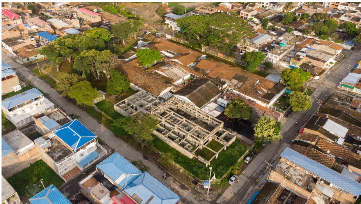
Figura 84. Fotos aéreas existente
