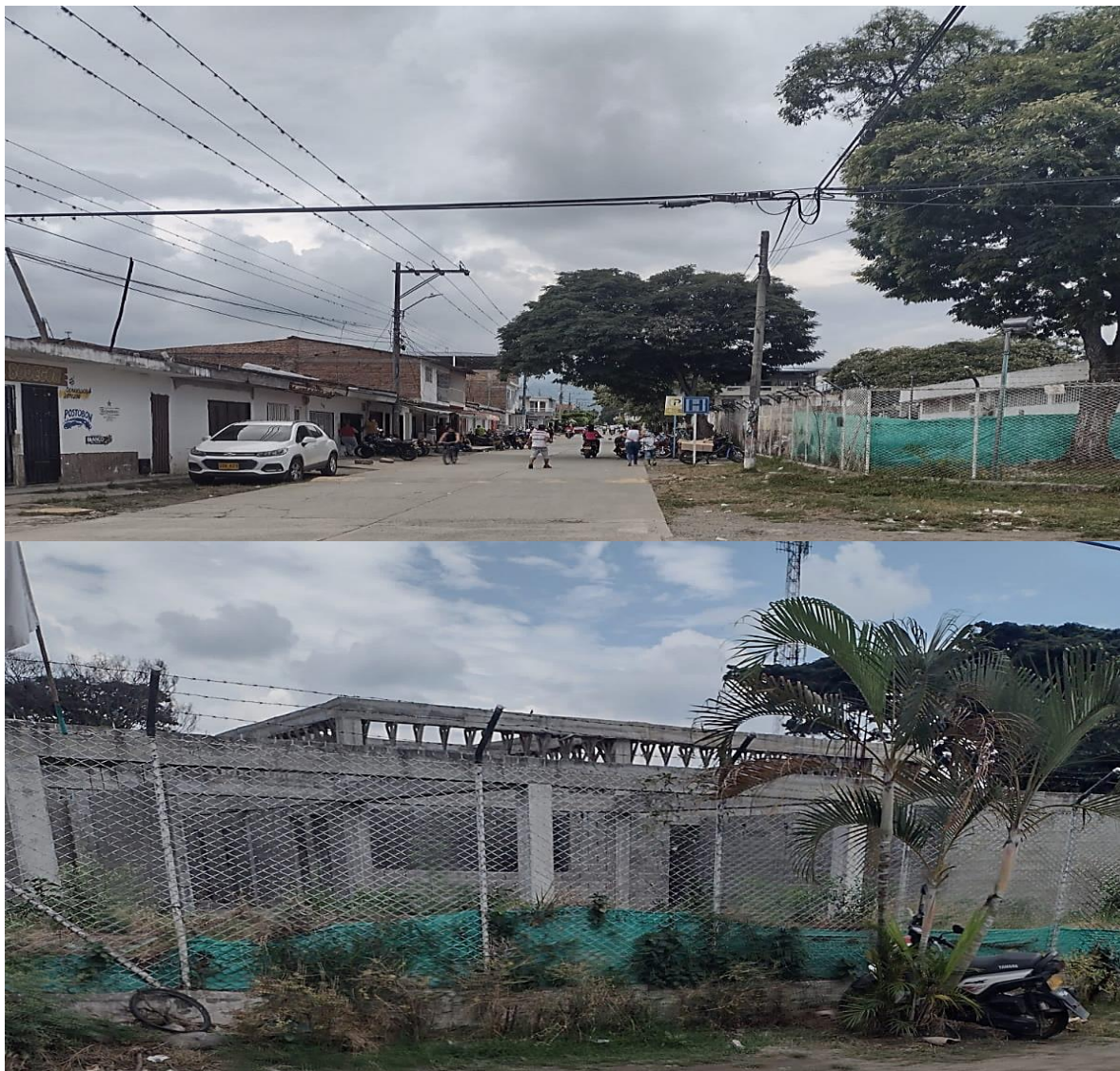
Figura 60. Imagen de la obra en abandono
