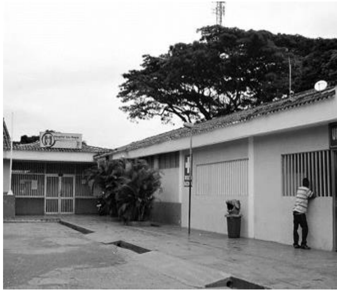
Figura 36. Entrada urgencias Hospital San Roque
