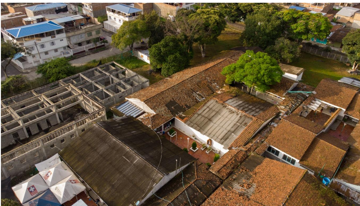
Figura 85. Fotos aéreas existente
