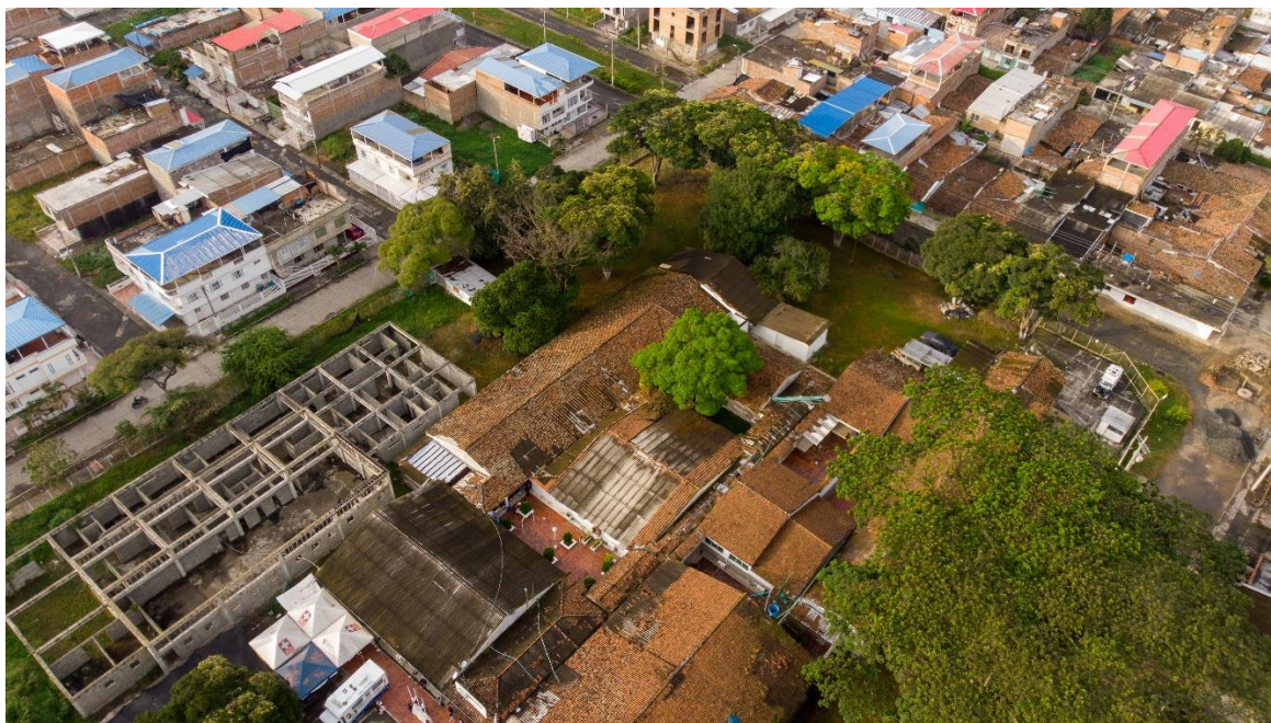
Figura 79. Fotos aéreas existente
