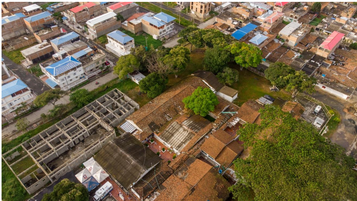
Figura 78. Fotos aéreas existente
