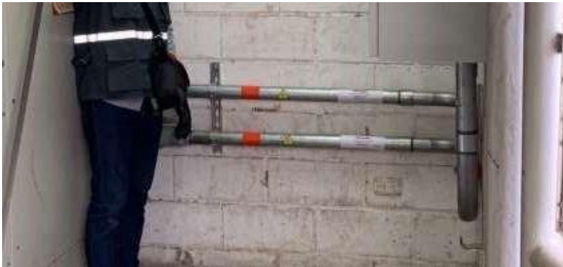
Figura 14: Marcación de tubería eléctrica.
