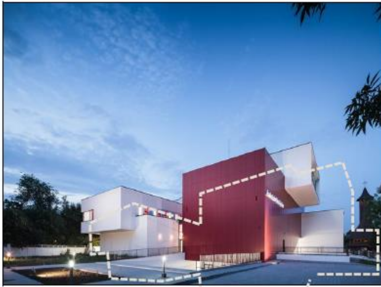
Figura 22. Vista de la fachada principal
