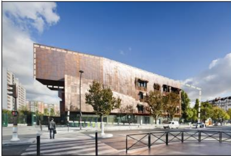
Figura 30. Vista de la fachada principal del conservatorio Fuente: Recuperado de http://hdl.handle.net/10757/621947
