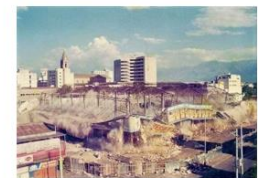
Demolición de Galería Central de Neiva años 1997. Tomado de Cabrera L. (2020)
