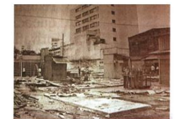
Demolición del Pasaje Camacho. Tomado de Historia Neiva (2020)
