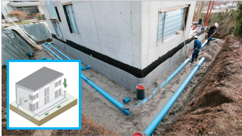
Figura 2-7. Intercambiador AWADUKT THERMO aplicaciones residenciales
