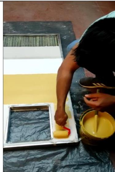
Se procede con aplicación de la pintura en estructura la cual También Evita que el producto metálico de inicio con su proceso de deterioro oxidación , se le aplican dos veces el producto para un mejor acabado .
