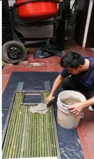
Se inicia con la instalación de la malla electrosoldada y la aplicación de la segunda capa de material pétreo, dando rigidez y mayor estabilidad a las varas de guadua, por tal motivo no hubo necesidad de elemento adicionales para su estabilidad.
