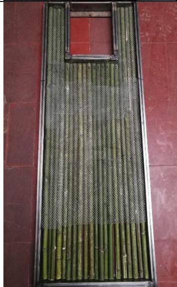
Después de la instalación del material vegetal se refuerza por ambos lados, se procede con la aplicación de la mezcla del material pétreo generando una mayor rigidez. En el anterior laboratorio se observó que estos dos materiales compaginan cuando son utilizados en dichas construcciones.
