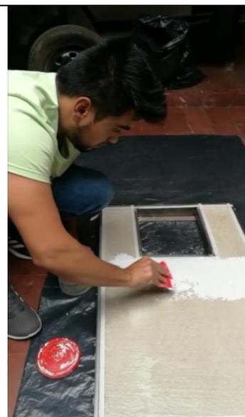
Se deja secar por dos días y medio y se inicia el proceso de eliminación de impurezas del estuco con una lija 180 y dejando el área donde fue aplicado el producto con el terminado deseado para esto se debe lijar una primera vez, se revisa las imperfecciones y se procede en solucionar por tal motivo toca dejar secar un día más para hay si realizar el último proceso anteriormente mencionado para después así proceder a la aplicación de la pintura .
