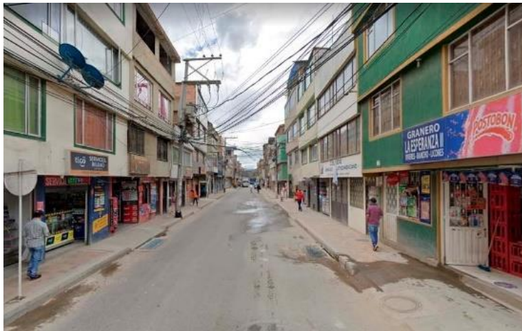
Foto 19: Estado actual de la Calle 147.
