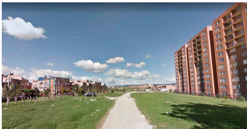
Foto 18: Estado actual de la Calle 145
