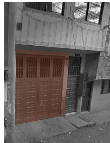
Imagen 38: Viviendas con bodegas
