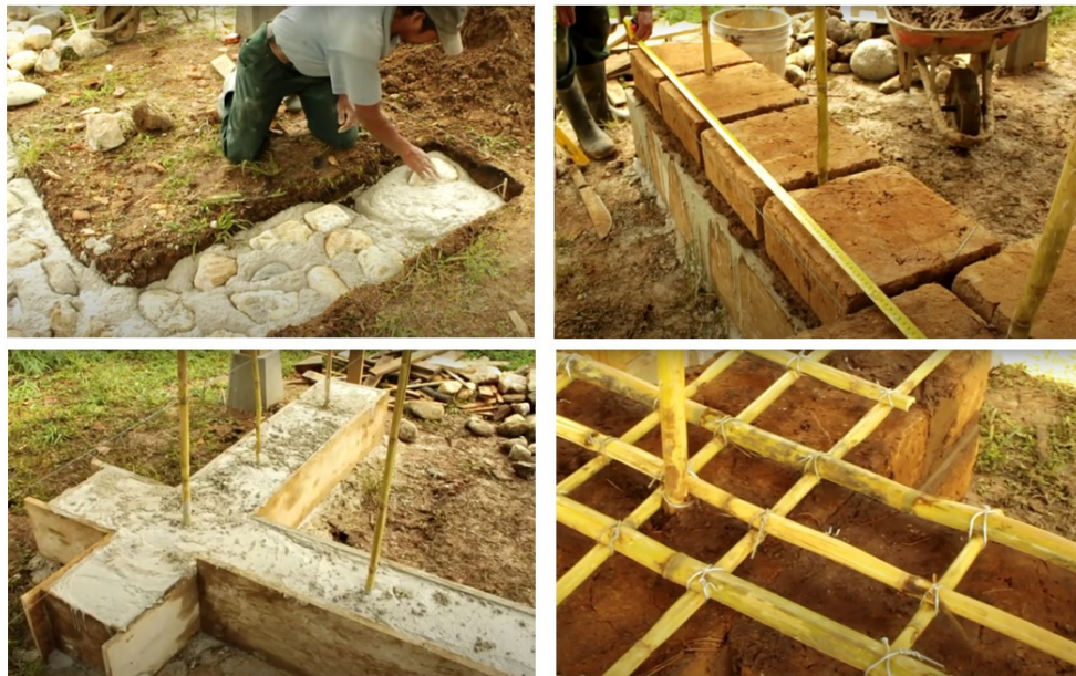
Imagen 6: Construcción con adobe sismo resistente.
