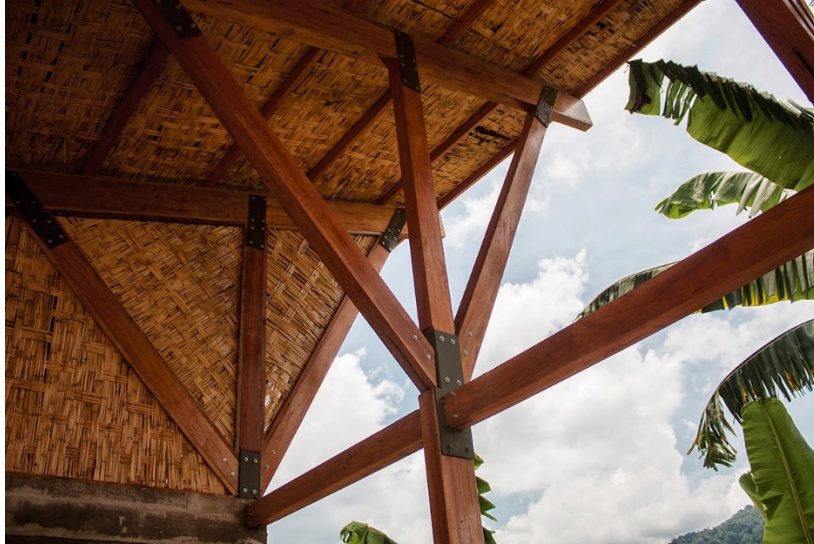
Imagen 9: Materialidad y técnica constructiva Colegio Chuquibambilla.
