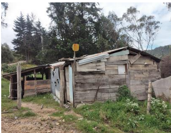
Imagen 22: Fotografía vivienda rural
