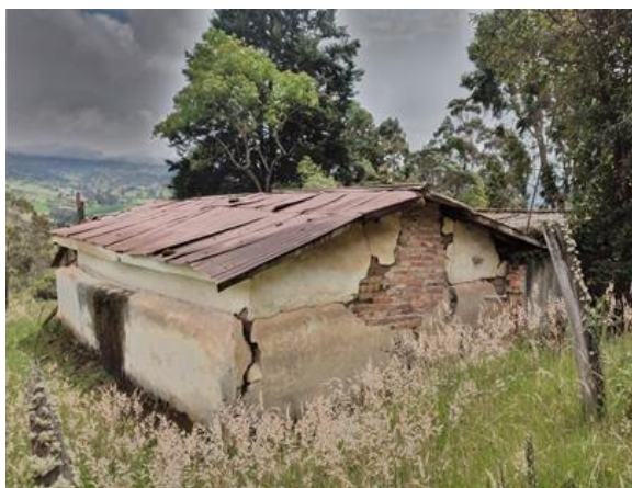
Imagen 23: Fotografía vivienda rural
