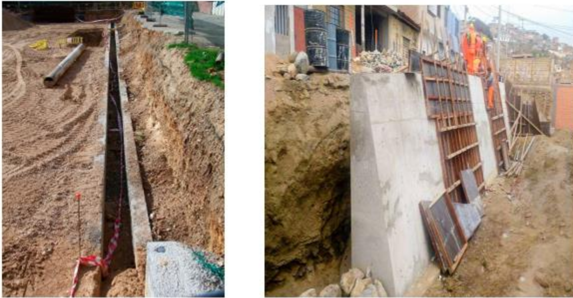
Figura 9. Muros y Pantallas de Contención
