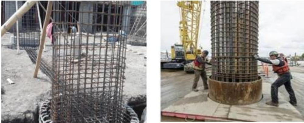
Figura 8. Construcción de un Caisson
