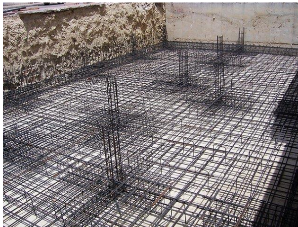
Figura 32. Cimentación Flotante
