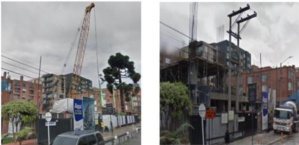
Figura 18. Proceso de Construcción Edificio Manglar Fuente: Google Earth
