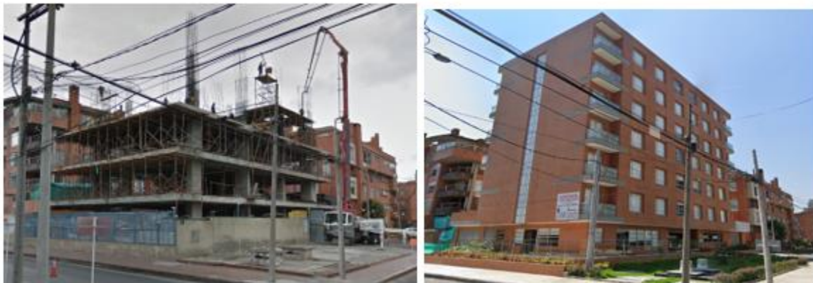
Figura 17. Construcción Edificio Manglar
