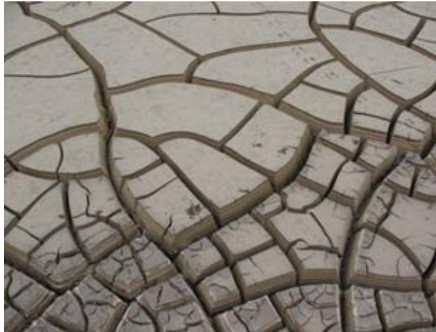
Figura 14. Arcillas Expansivas y Suelos Expansivos En Edificación Fuente: https://archxde.com/arcillas-expansivas/
