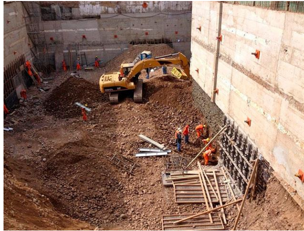
Figura 35. Muro de Pantalla
