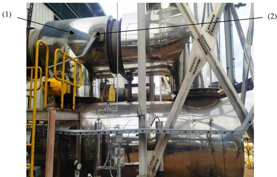
*Nota.* (1) Ducto de gases de combustión. (2) *Damper*. Tomado en zona de patios fase 2, planta de generación del Meta.
