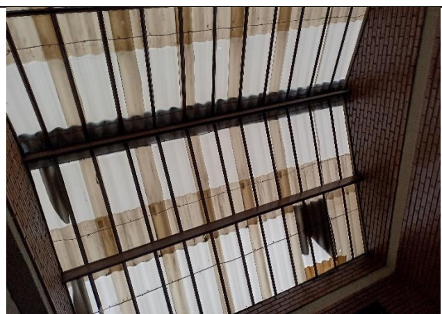
Estado de la cubierta.
