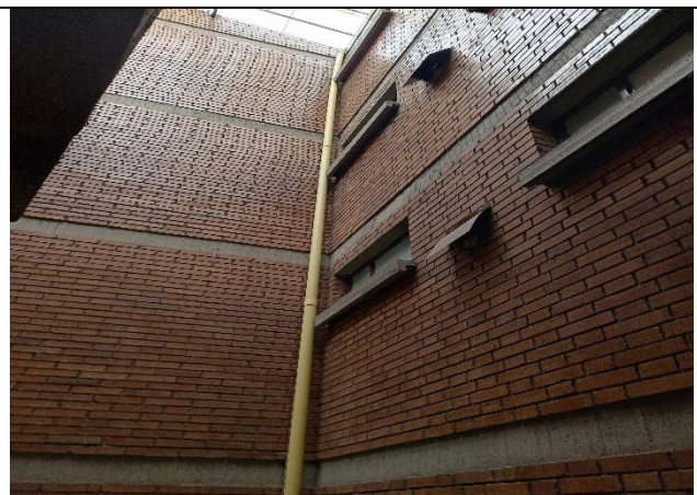
Bajante de agua lluvia.
