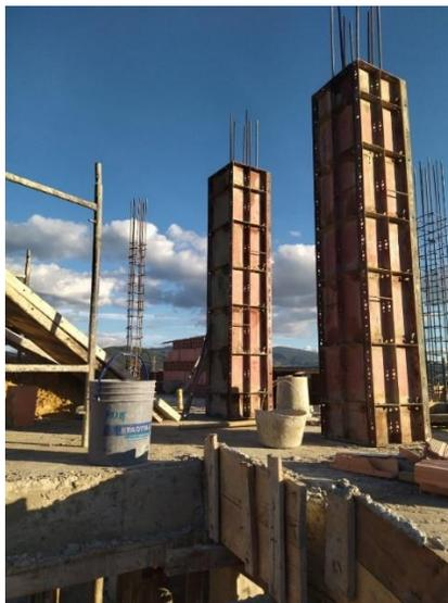
*Nota:* En la imagen se ve dos columnas ya encofradas y fundidas en proceso de secado y en la parte trasera se ven dos columnas que aún están sin encofrar.
