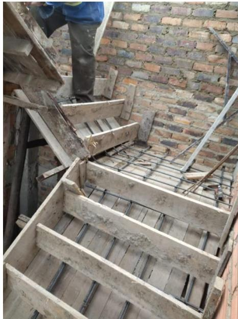
*Nota:* En la figura se evidencia la implantación de aceros y madera para afirmar, además dar forma a la construcción de la escalera
