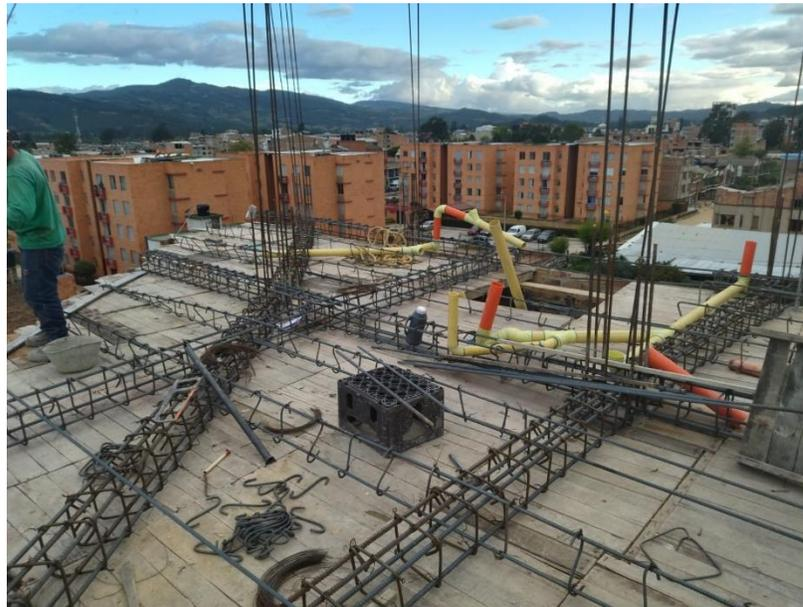
*Nota:* En la figura se observa la construcción de las vigas de amarre, vigas internas y vigas riostras que conformaran la placa de entre piso.
