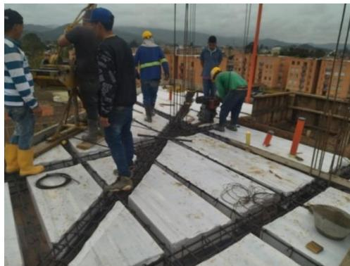
*Nota:* En la figura se observa la impuesta de aligeramiento (casetón) momentos antes de fundir la placa de entre piso
