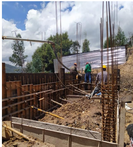
Figura 16. Vigas y muro en proceso de fundición.
