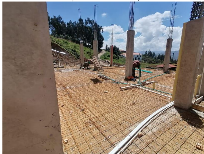
Figura 18. Malla electrosoldada, tubería eléctrica, sanitaria hidráulica y de gas instalada.
