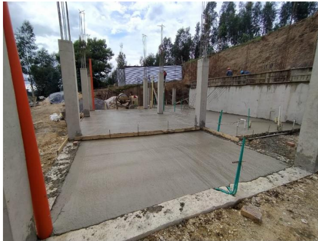
Figura 19. Placa de cimentación fundida
