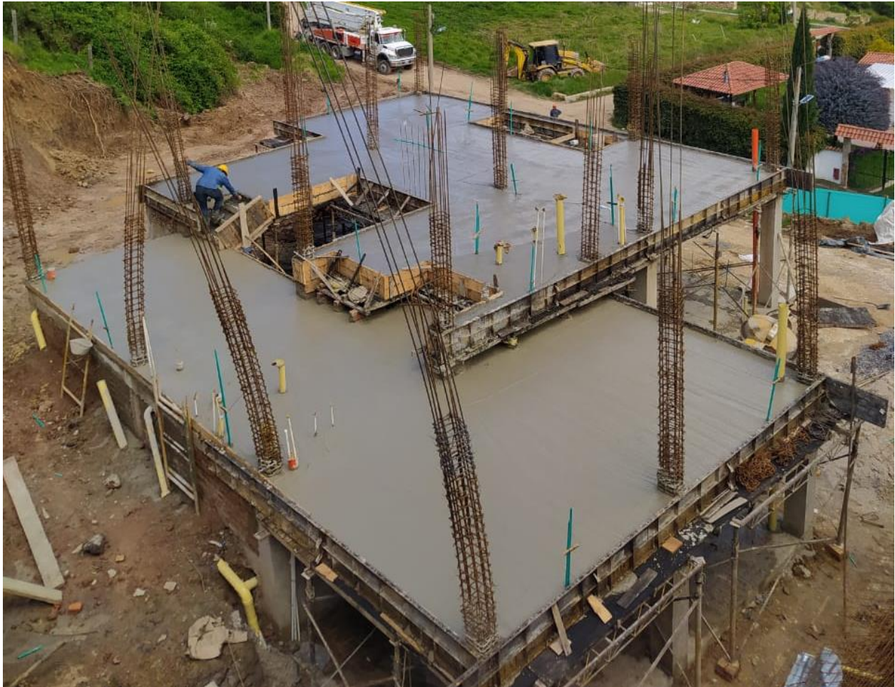
Figura 21. Obra Cabaña Bachue ACTUAL
