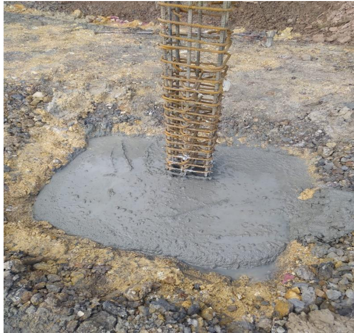
Figura 12. Zapata fundida
