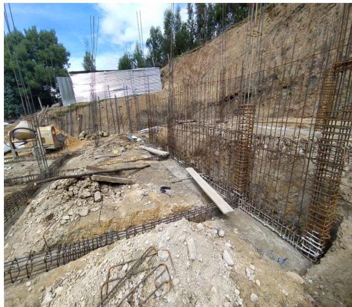
Figura 14. Columna y muro de contención con su amarre de hierro correspondiente
