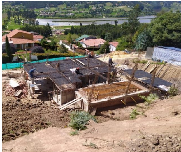
Figura 20. Instalación de camillas casi completa
