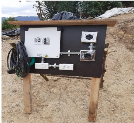
Figura 15. Instalación luz provisional
