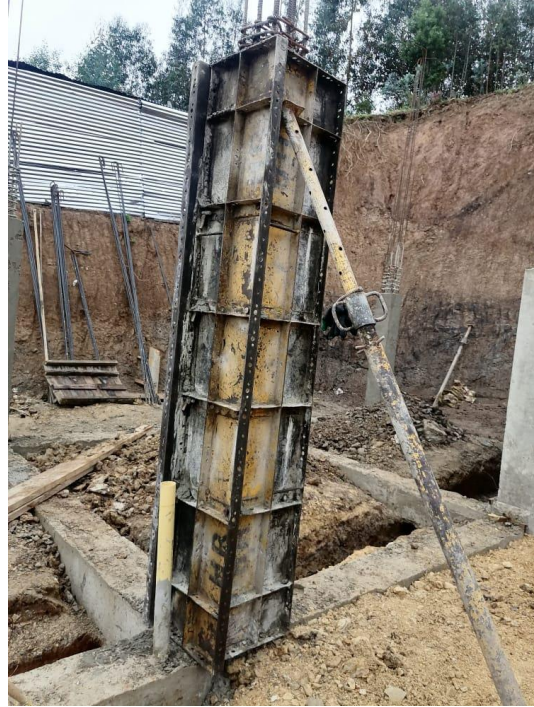
Figura 17. Columnas en proceso de fundición.
