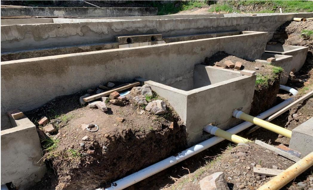
Nota. Visita a la planta de tratamiento de agua potable, para verificación de avance de obra en tanque desarenador
