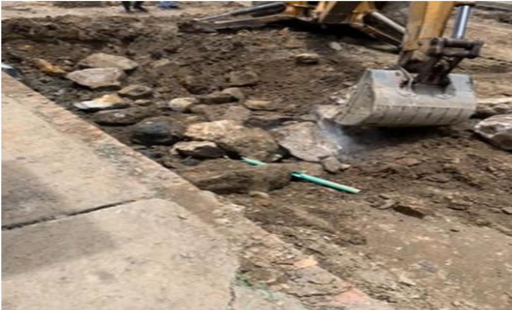
*Nota.* Seguimiento a la obra del proyecto “Construcción y mejoramiento de sistema de acueductos y alcantarillado”. Relleno con grava en zonas de acolchonamiento debido a la presencia de suelos húmedos arcillosos.
