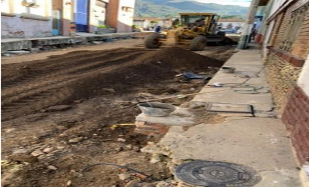
*Nota.* Inspección al proceso de extendido de material granular en el proyecto “Construcción y mejoramiento de sistema de acueductos y alcantarillado”.
