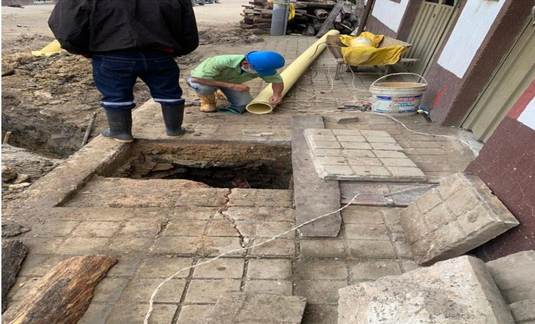
*Nota.* Apoyo en la supervisión de acometidas para tubería de aguas residuales en el proyecto de construcción, mejoramiento y/o reposición sistema de acueducto y alcantarillado de las vías carrera 4 entre calles 5 y 6 en el municipio de Mongua departamento de Boyacá.
