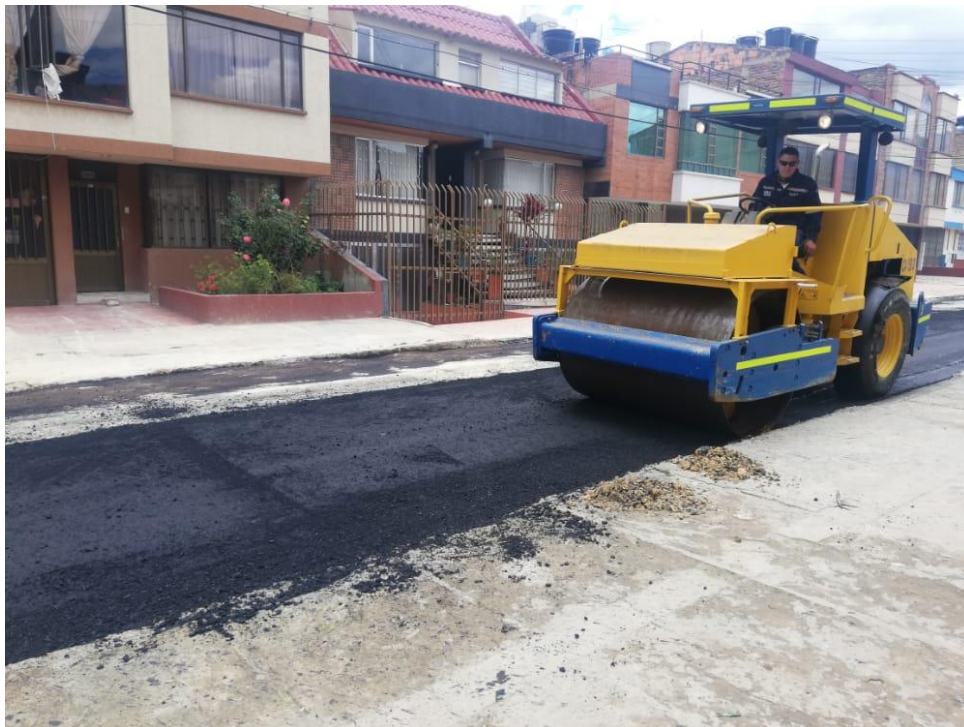
Anexo M. Compactación de Mezcla Asfáltica
