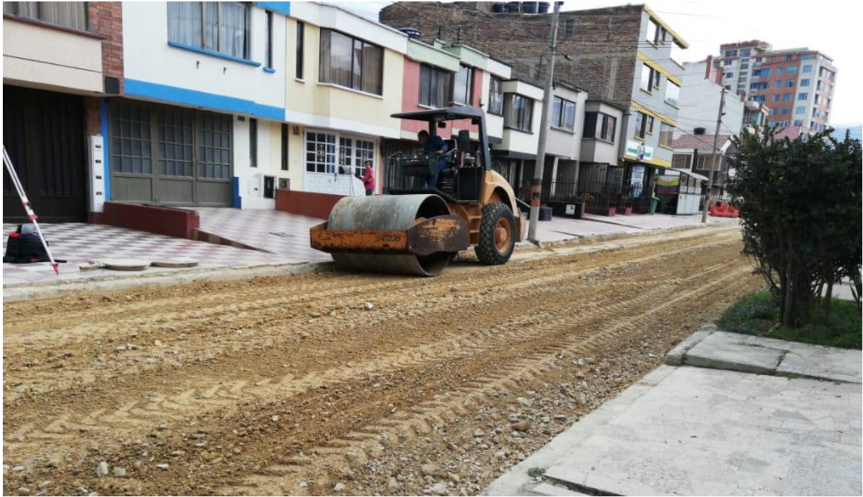
Anexo J. Compactación de Terreno
