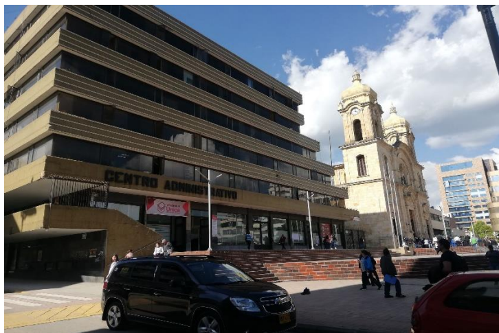
Figura 2. Instalaciones alcaldía municipal de Duitama
