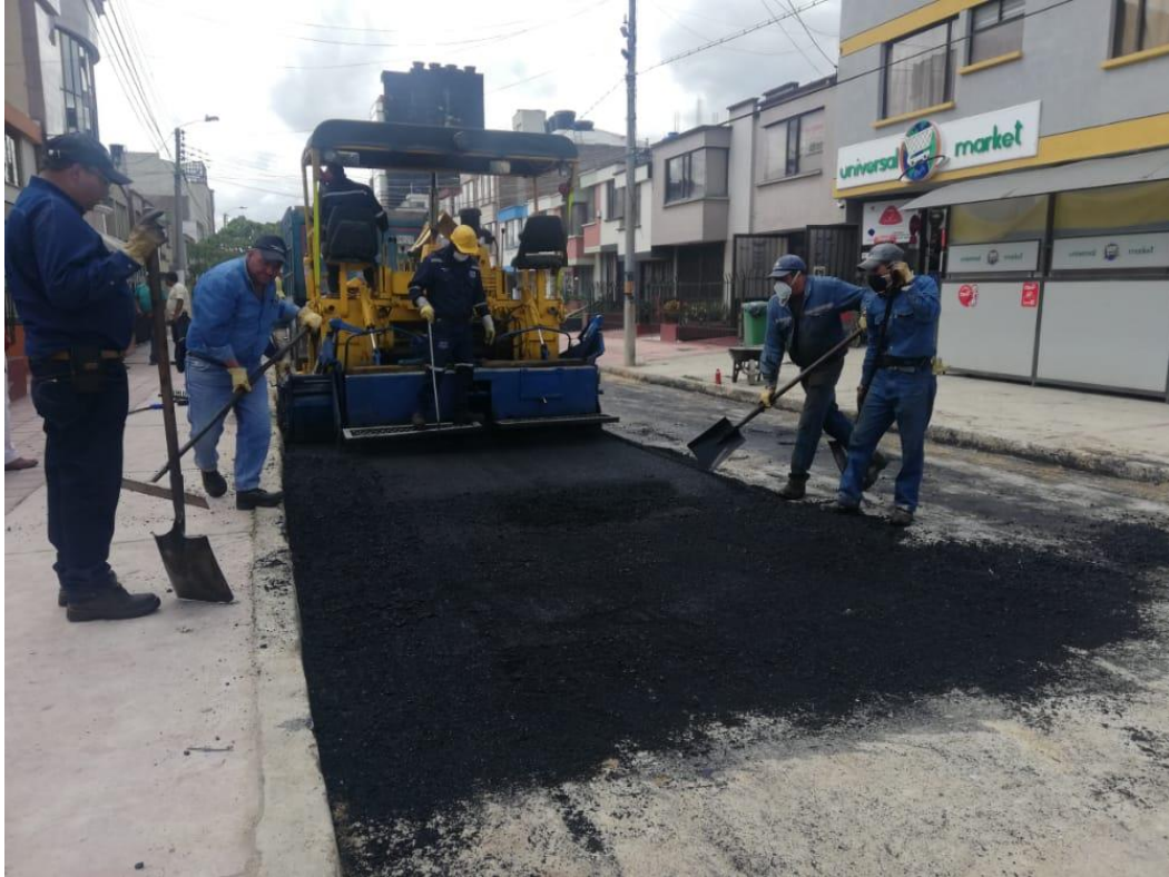
Anexo M. Compactación de Mezcla Asfáltica
