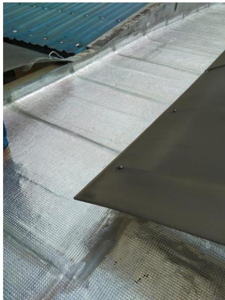
*Nota:* La figura muestra el resultado de la impermeabilización de la cubierta del ancianato mediante la instalación de manto Fiberglass. Fuente: Elaboración propia.
