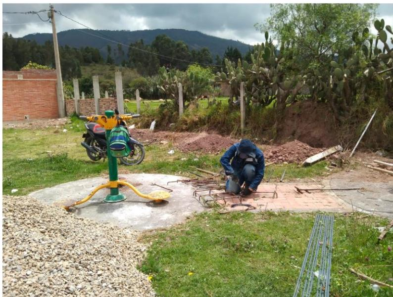
*Nota:* En la figura se muestra la ejecución de la obra, en donde se realiza el cerramiento al parque, iniciando por la construcción de columnas y muro prensado. Fuente: Elaboración propia.
