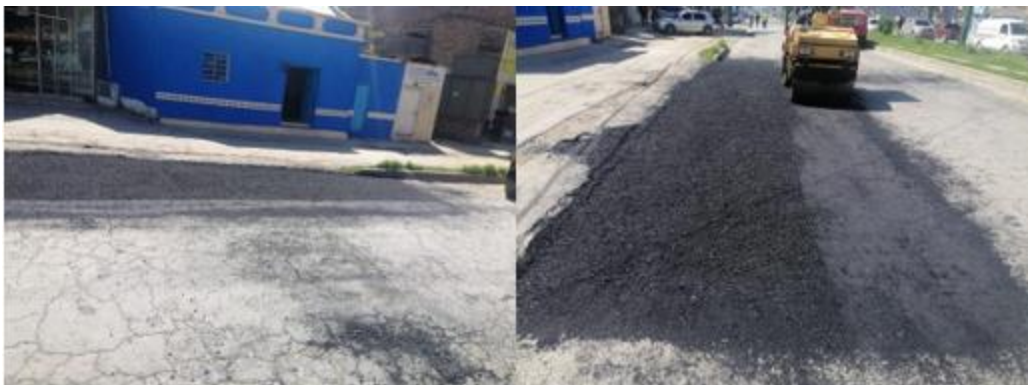
Figura 12. Registro fotográfico, compactación de mezcla asfáltica, vía las Américas.
