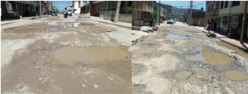
Figura 10. Registro fotográfico, diagnóstico vial, Carrera 43, Barrio Juan Grande.
