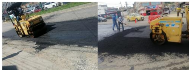
Figura 13. Registro fotográfico, distribución y compactación de mezcla asfáltica, vía las Américas.
