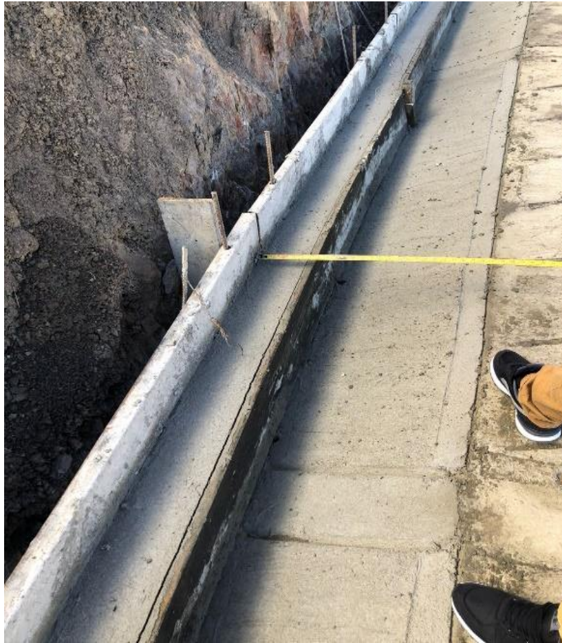
Figura 53 Fundida de bordillo y cunetas
