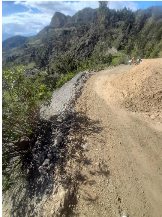
Figura 41 Suministro de material granular
