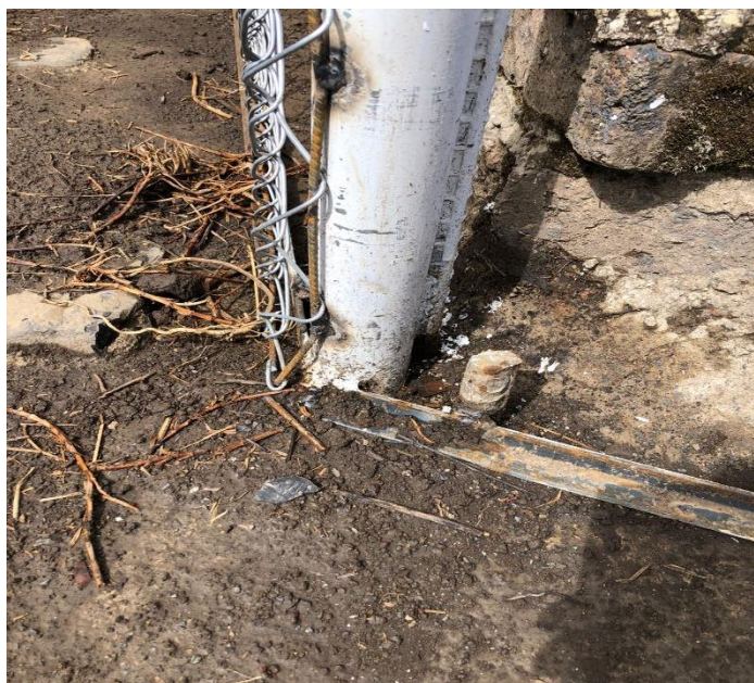
Figura 29 Instalación de tubería aguas negras
