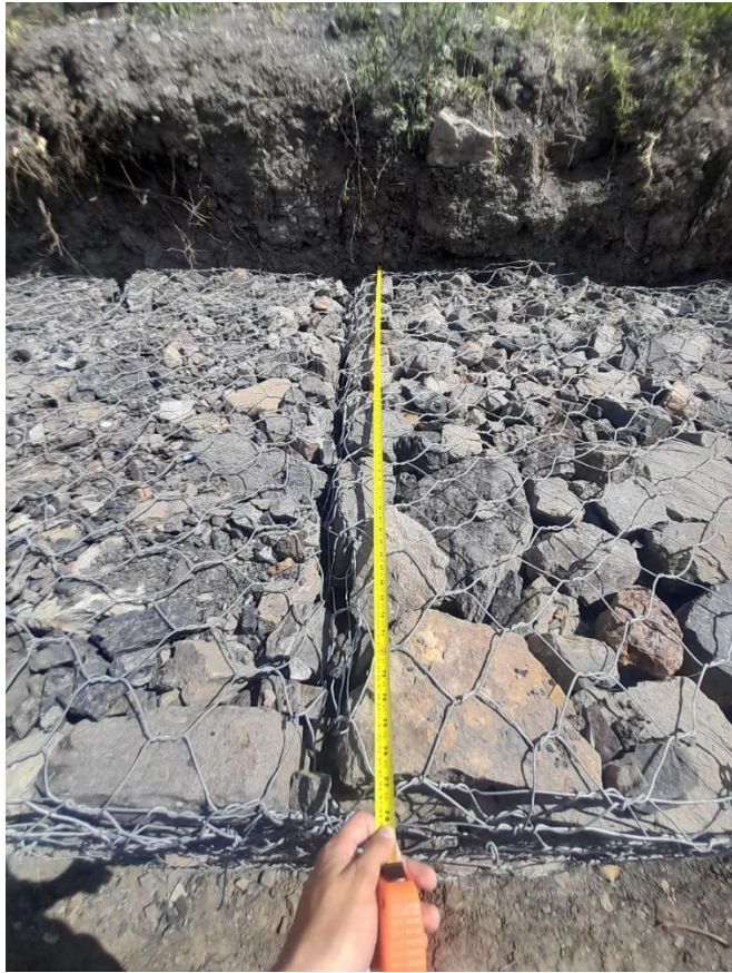
Figura 37 Verificación de medida de gaviones
