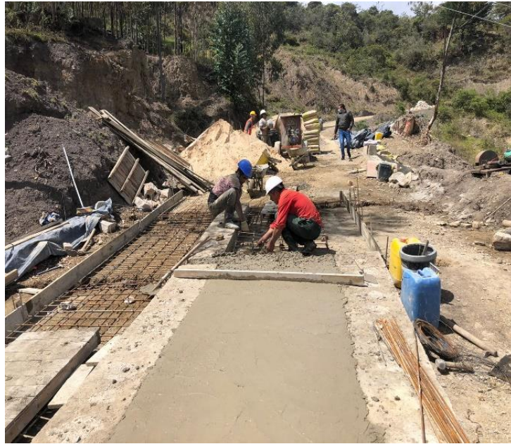
Figura 50 Fundición de placa huella
