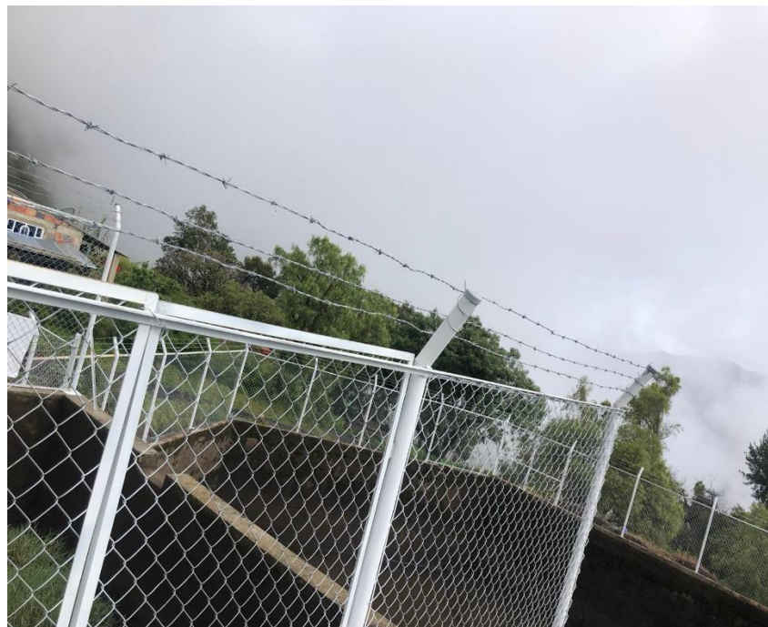
Figura 32 Instalación de alambre de púa
