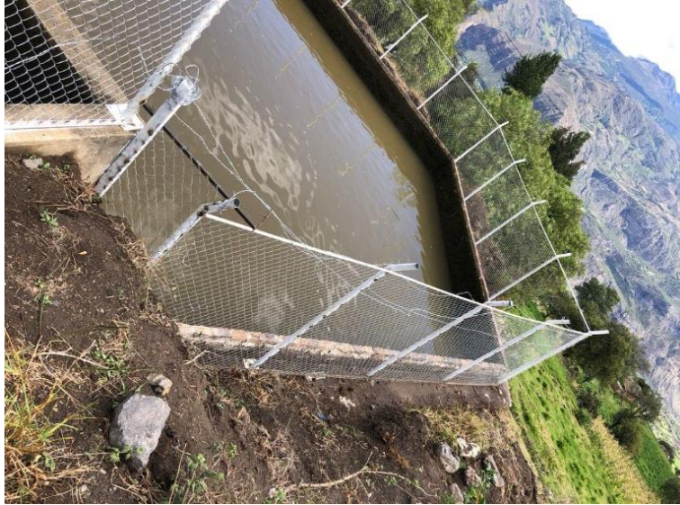
Figura 25 Construcción de cerramiento
