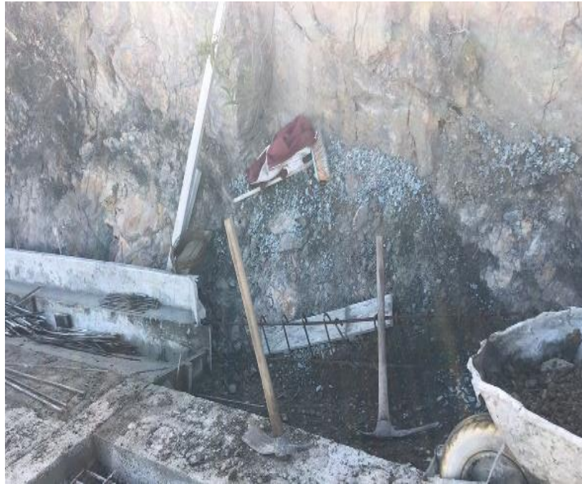
Figura 51 Excavación para cuneta
