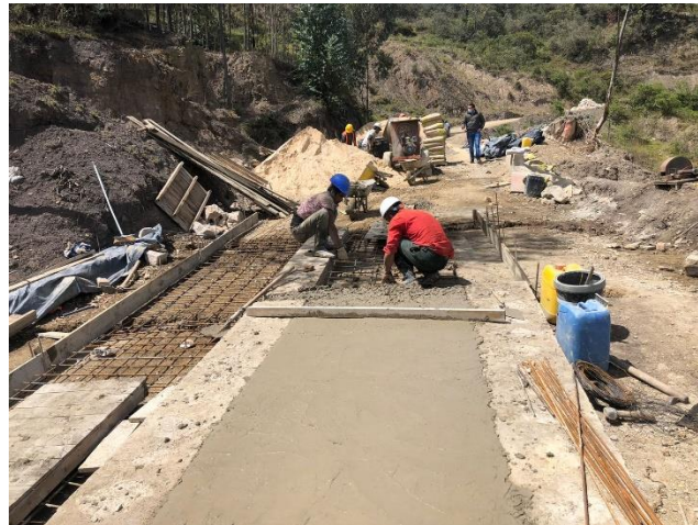
Figura 9 Fundida de las huellas y vigas riostras
