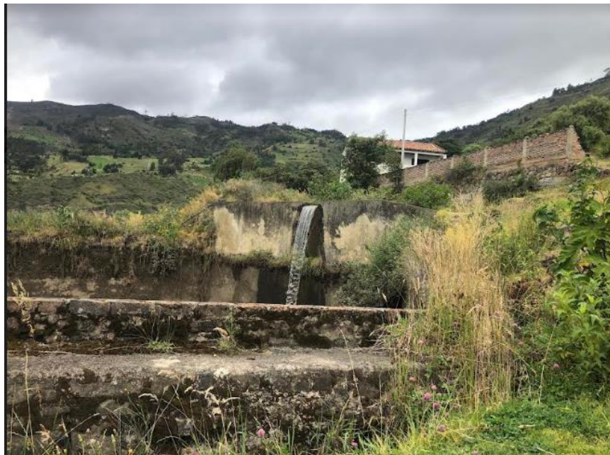
Figura 28 Visita a tanque antes de cerramiento
