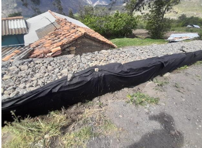
Figura 35 Instalación de geotextil
