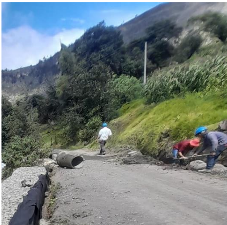
Figura 38 Excavación para la instalación de tubos
