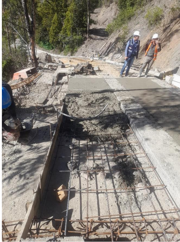
Figura 46 Amarre de acero y fundición de placa
