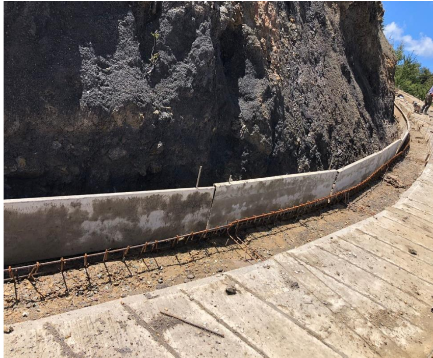
Figura 52 Amarre para fundir cuneta y bordillo
