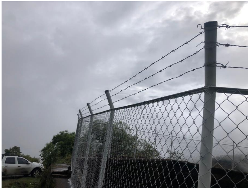
Figura 27 Instalación de alambre de púa
