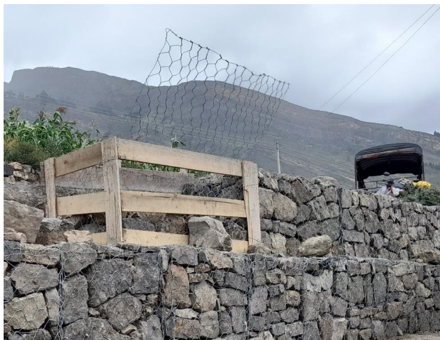
Figura 36 Instalación de malla eslabonada cal 12
