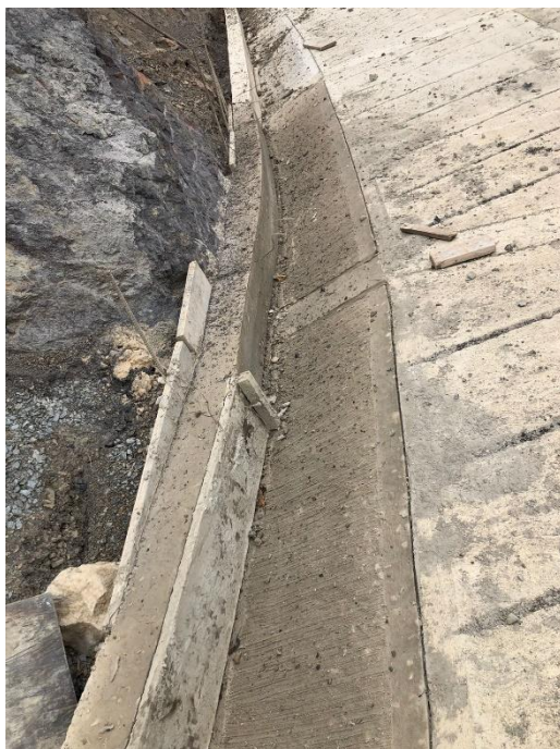
Figura 11 Ejecución cunetas y bordillos
