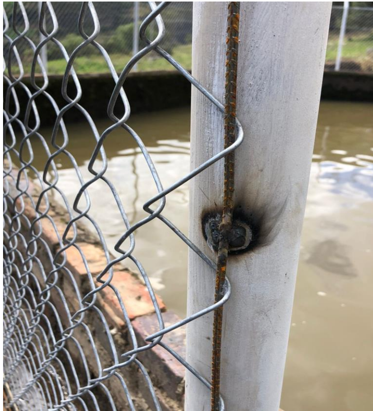
Figura 30 Instalación de malla eslabonada
