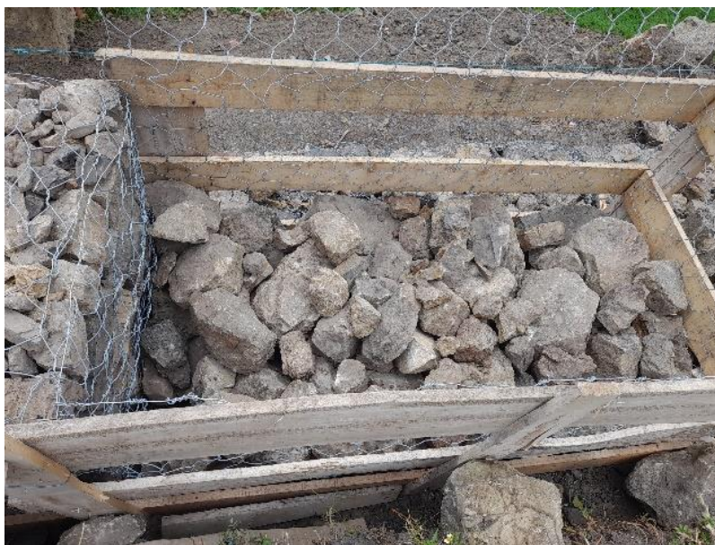
Figura 34 Instalación de agregado rocoso
