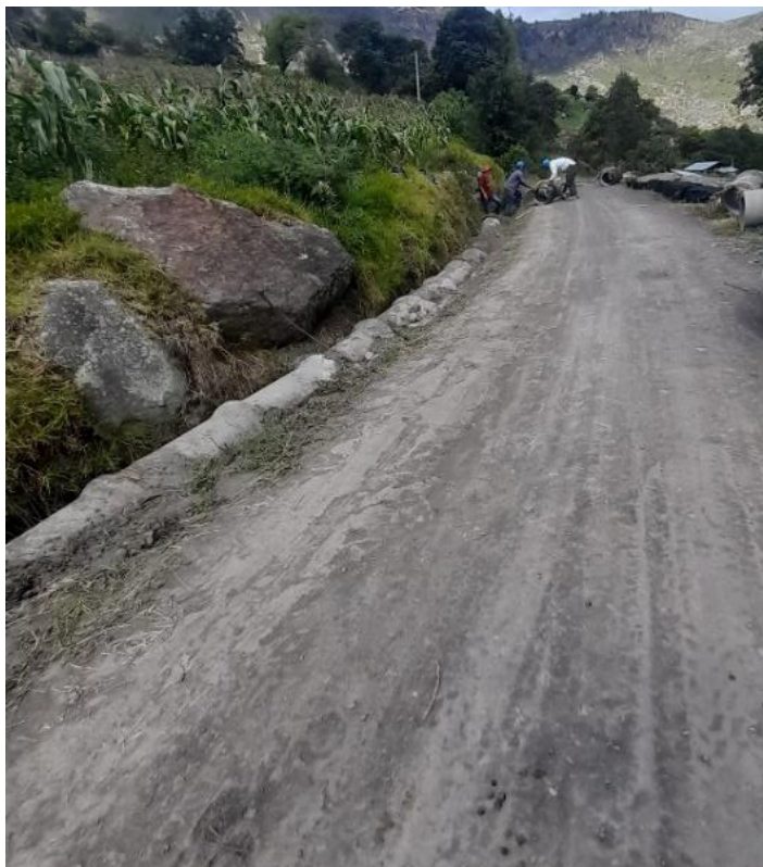
Figura 39 Suministro e Instalación de tubos
