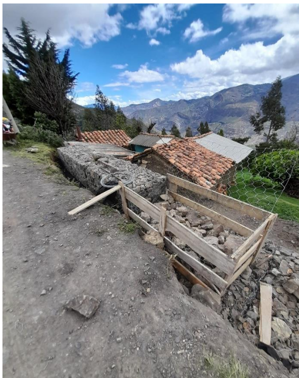
Figura 33 Construcción de gaviones
