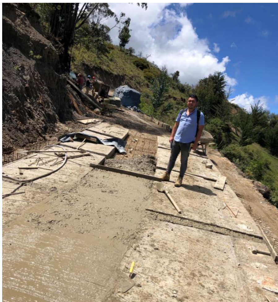
Figura 49 Fundición placa huella
