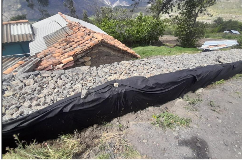
Figura 21 Instalación de geotextil
