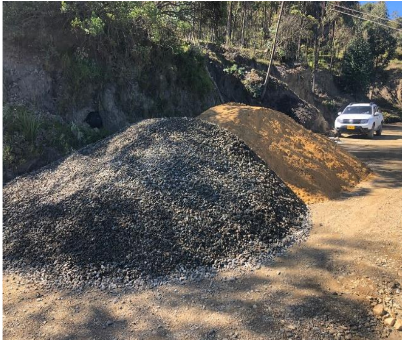
Figura 54 Verificación de materiales
