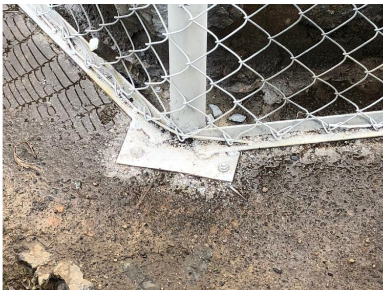
Figura 31 Instalación de platinas
