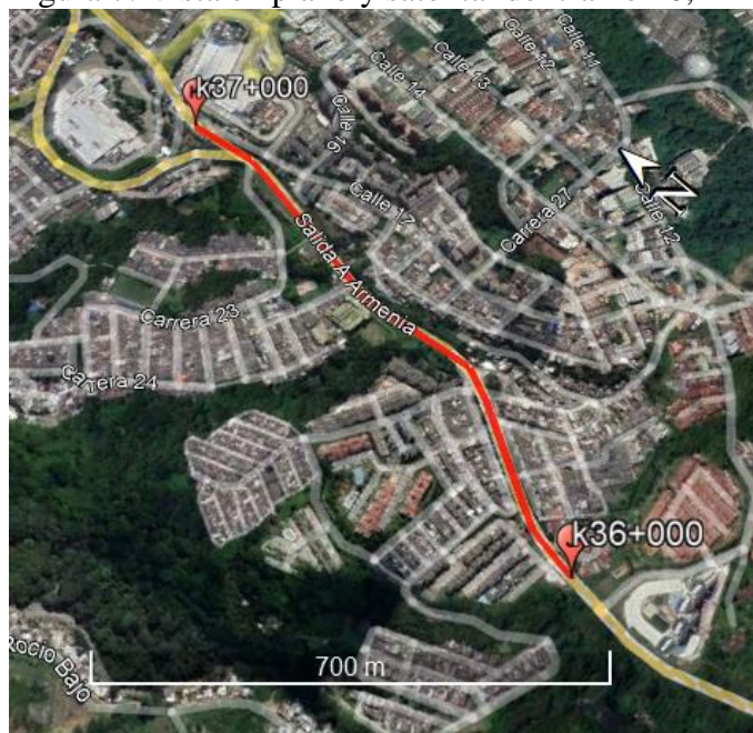
Figura 7. Vista en plano y satelital del tramo 10, km 36+000 - km 37+000
