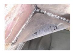
**Figura 28**Detalle anclaje de IPE.
