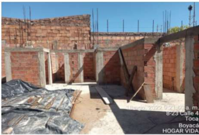
Descripción: VIGA AMARRE SOBRE MURO 21 MPa - (3000 PSI).
