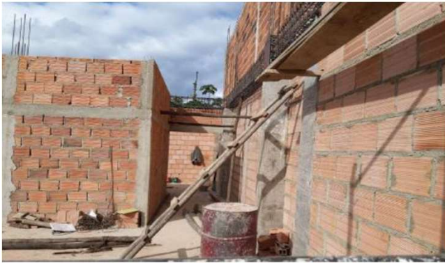
Descripción: mamposteria en bloque numero 5 en pasillos y suministro figurada y amarre de acero
