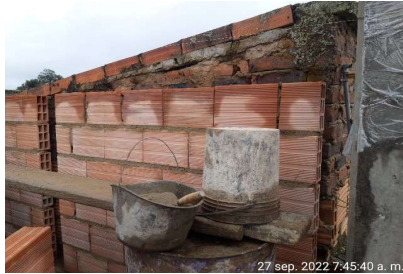
Descripción: muros no mayores a 1.30 m
