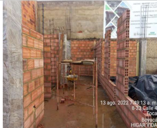
Descripción: mamposteria n° 5 fachada
