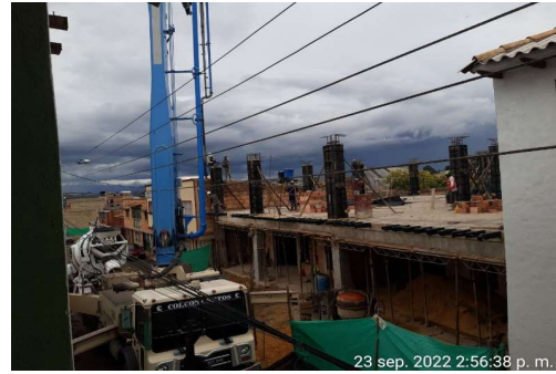
Descripción: vaciado de concreto en columnas
