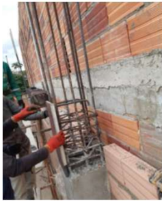
Descripción: SUMINISTRO E INSTALACION DE PLATINA 3/4", INCLUYE RIGIDIZADOR 5/8" Y VARILLAS EMBEBIDAS 5/8
