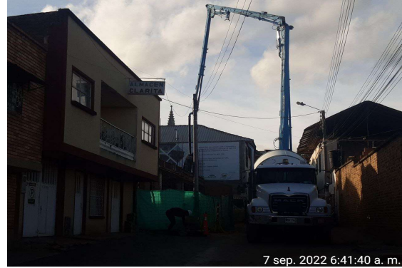
Descripción: vaciado de concreto en vigas
