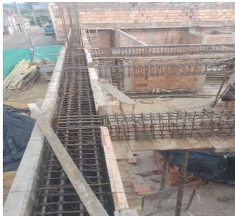
Descripción: formaleta de fachada
