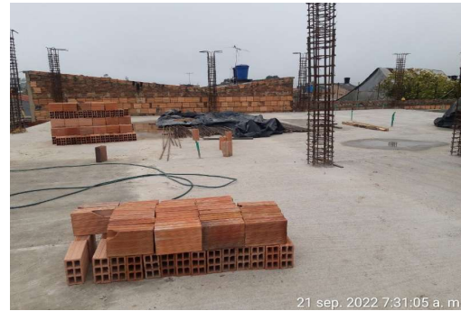
Descripción: instalacion de acero en columnas +3.20 a 6.40
