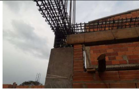
Descripción: SUMINISTRO FIGURADA Y AMARRE DE ACERO 60000 PSI 420 Mpa
