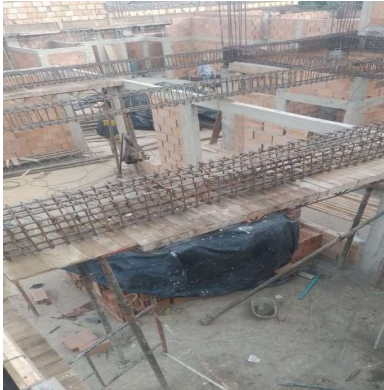
Descripción: formateado de vigas +3.20
