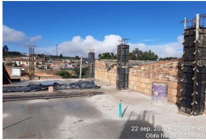
Descripción: formateo de columnas
