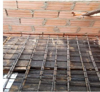
Descripción: armado de escalera
