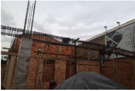
Descripción: SUMINISTRO FIGURADA Y AMARRE DE ACERO 60000 PSI 420 Mpa
