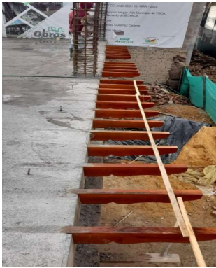
Descripción: instalacion de canes
