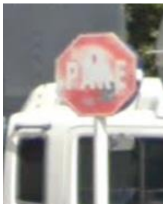
Figura 35. Señalización de PARE, poco visible
