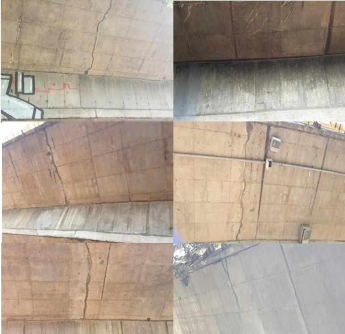
Nota: Fisuras generadas por fatiga del material de las losas de concreto. Adaptado de (Elaboración propia).
