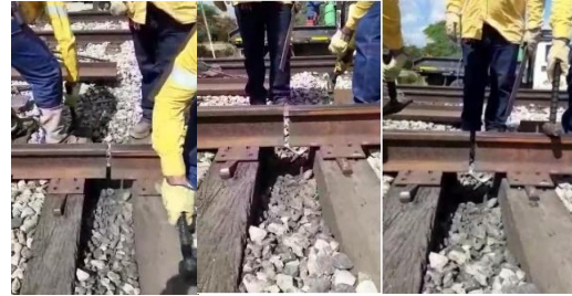
Figura 3. Proceso de alineación de forma manual. Fuente: Equipo de trabajo de grado.
