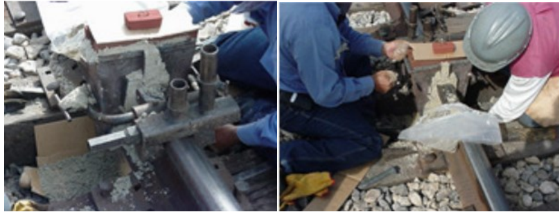
Figura 9. Instalación de moldes.
