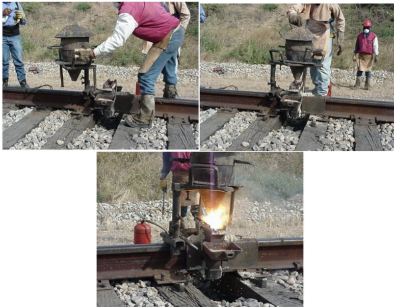
Figura 10. Precalentamiento de soldadura.
