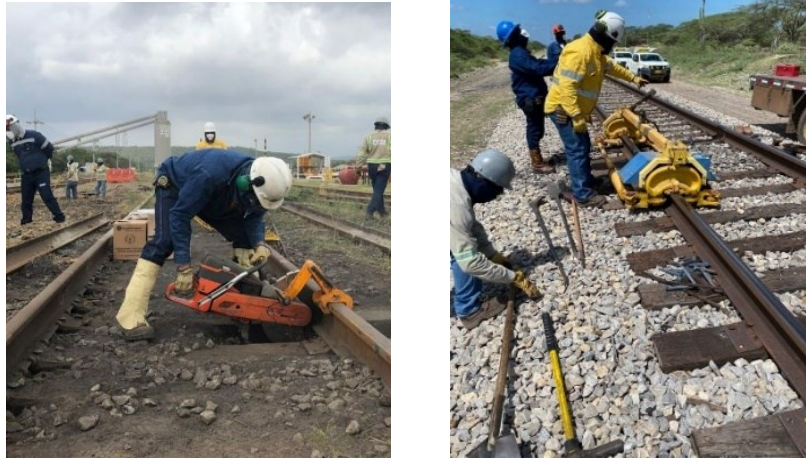
Figura 7. Corte y reemplazo de riel.
