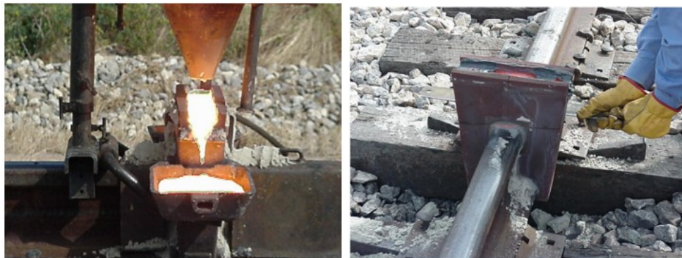
Figura 11. Evacuación de crisoles y retiro del desechable.
