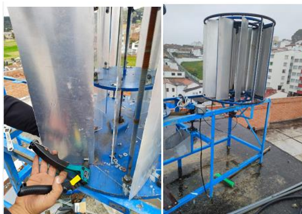
Figura 32. Colocación y Reemplazo de las Hélices
