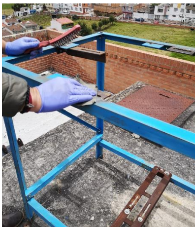
Figura 23. Lijado de la Estructura Base de las Turbinas
