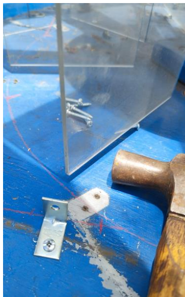
Figura 27. Instalación de L para Soporte de las Láminas de las Hélices
