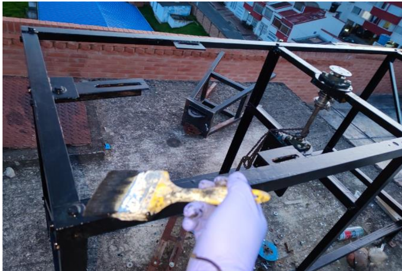
Figura 31. Pintura Sobre Estructura de Base de las Turbinas Eólicas de Eje Vertical
