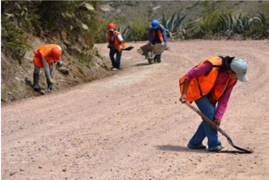
Figura 20. Mantenimiento rutinario de una vía terciaria.
