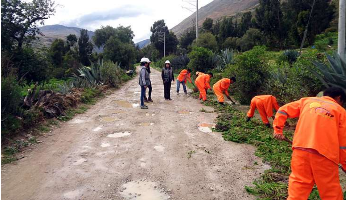
Figura 29. Rehabilitación de una vía terciaria.
