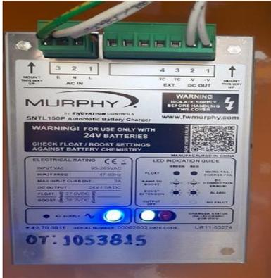
Fig. 10. Cargador de baterías. foto tomada de un grupo electrógeno Caterpillar
