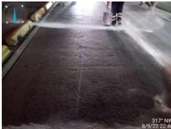
Figura 14. Vista típica de losa con pulimiento (PU) (Elaboración propia).
