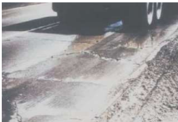
Figura 22. Vista típica de expulsión de material por bombeo (BOT-BOL) (INVIAS, 2006).
