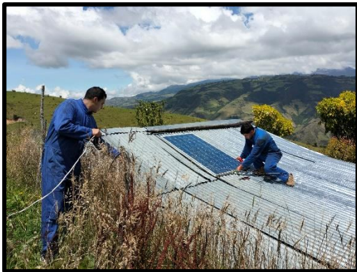
Figura 10. Ubicación del panel solar en el techo
