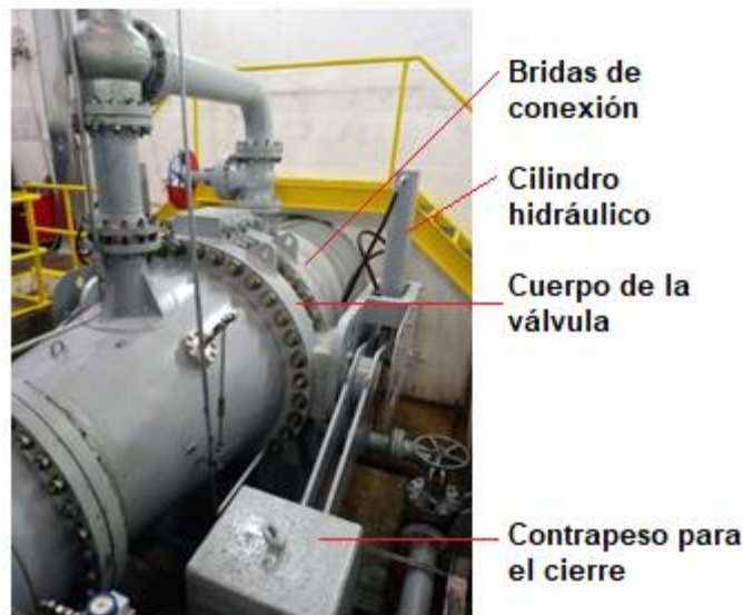
Figura 8. Válvula de admisión con contrapeso
