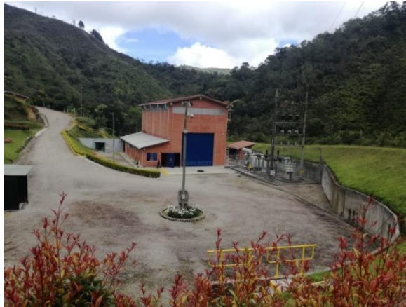
Figura 5. Edificación de casa de máquinas
