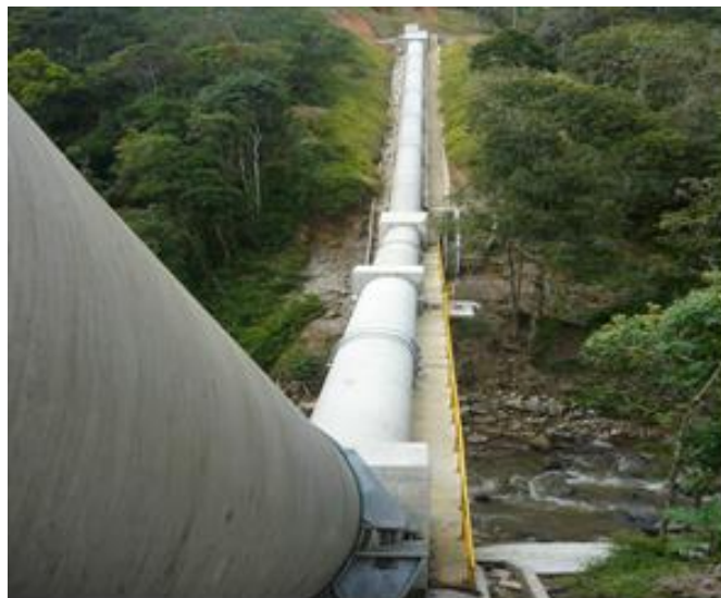
Figura 2. Canal de conducción PCH Guanaquitas
