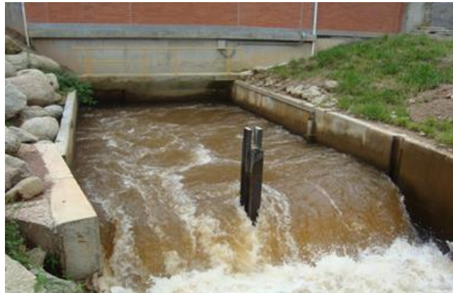
Figura 6. Canal de descarga Guanaquitas
