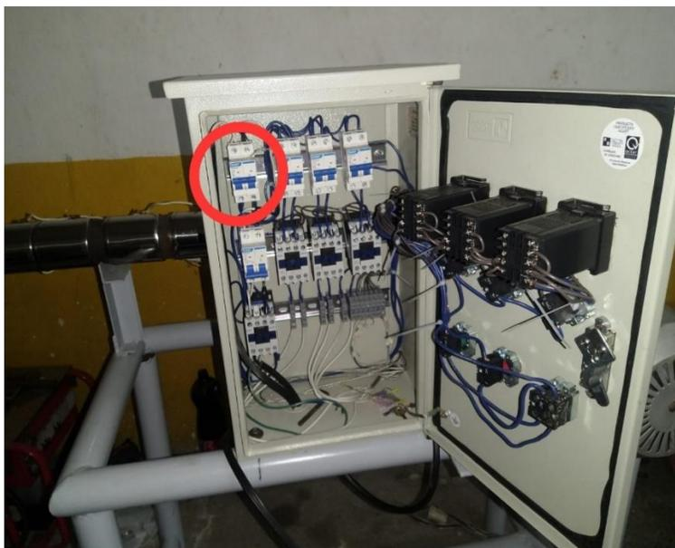
**Segundo paso:** posicionar a "ON" los conmutadores para encender los controladores de temperatura.
