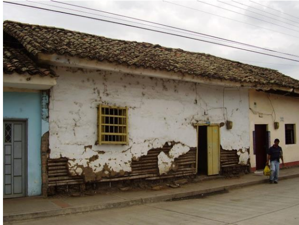
Ilustración 7 Construcción en Bahareque, Colombia (Rivera, 2022)
