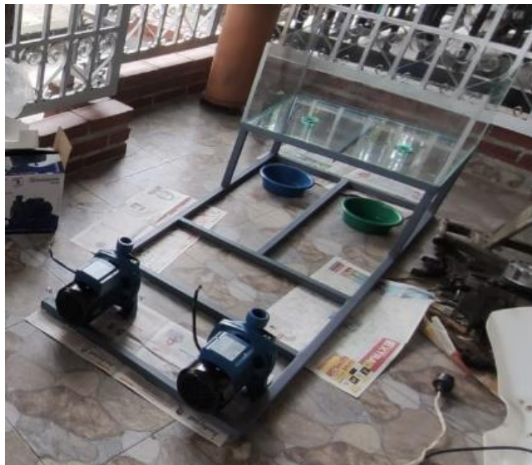
Figura 10.10 Montaje del tanque
