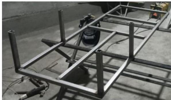
Figuras 10.4 Fabricación de la estructura
