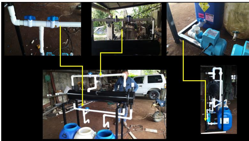
Figura 5- 8 Instalación de válvulas de cierre y paso de líquidos
