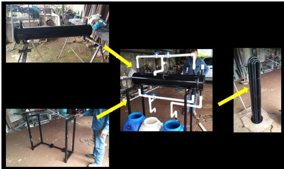
Figura 5- 7 Pintado con material anticorrosivo.
